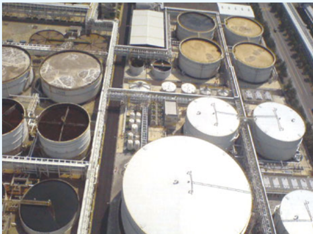
廢水處理場 (改善前)
