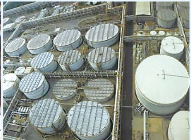
廢水處理場 (改善後)
