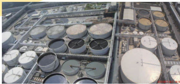
廢水處理場 (改善前)
