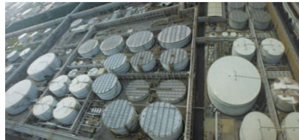
廢水處理場 (改善後)
