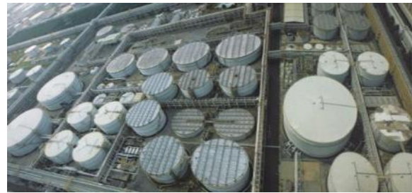
廢水處理場 (改善後)
