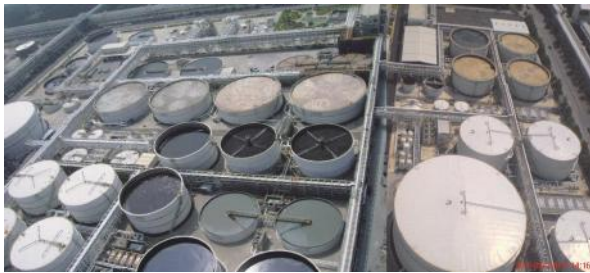
廢水處理場 (改善前)
