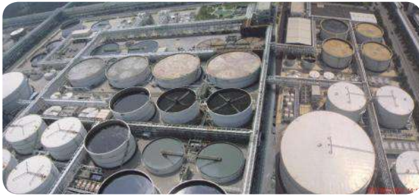
廢水處理場 (改善前)
